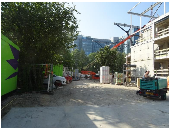
Hazelaar en meelbes op bouwplaats
